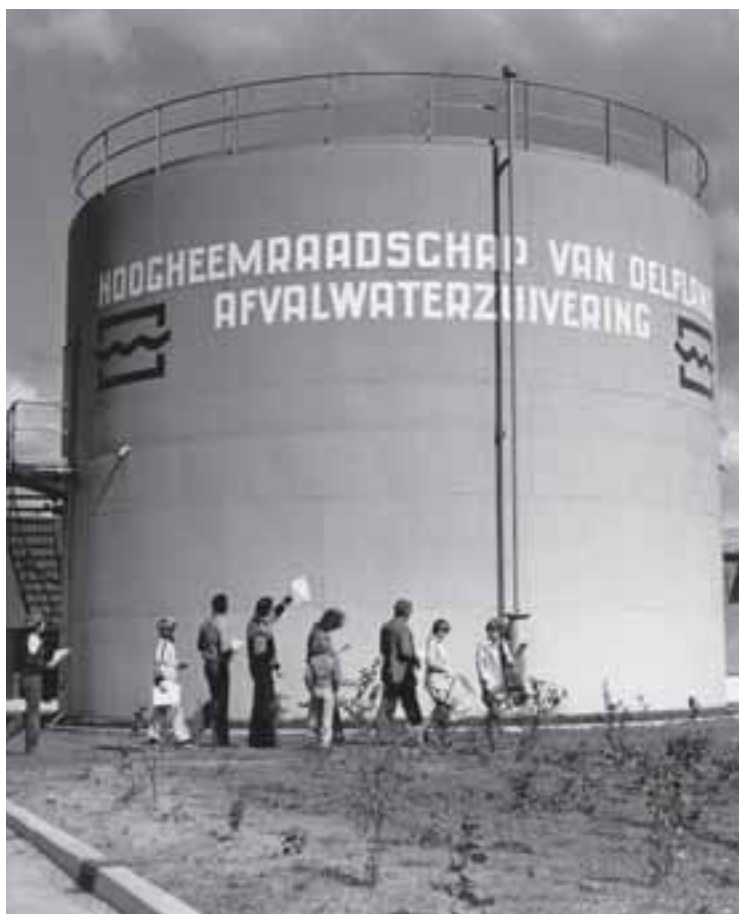
3. Detailopname van de RWZI: gashouder. Bron: fotoverzameling hoogheemraadschap van Delfland.
