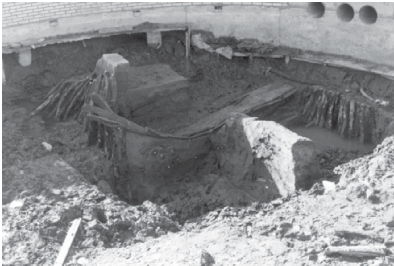
Eén van de Romeinse duikers te Hoogstad, gelegen exact in het verlengde van een moderne duiker die net is aangelegd. Aan weerszijden van de duiker is een dichte paalzetting te zien die tezamen met het aardlichaam ertussen een dam vormde (Foto: Bureau Archeologie en Monumentenzorg, Vlaardingen).
