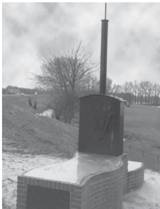
Spindelschuif van de Erlecomse dam (foto: J.A.E. Kuys).
