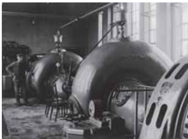
Foto van het interieur van gemaal de Ruiter bij Demmeriksesluis, ca. 1925.
