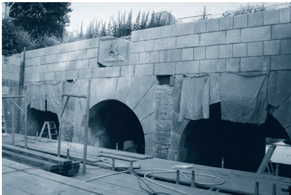
Afb. 1. De inundatie-sluis bij Westdorpe tijdens de restauratie (foto Nellie de Kraker).
