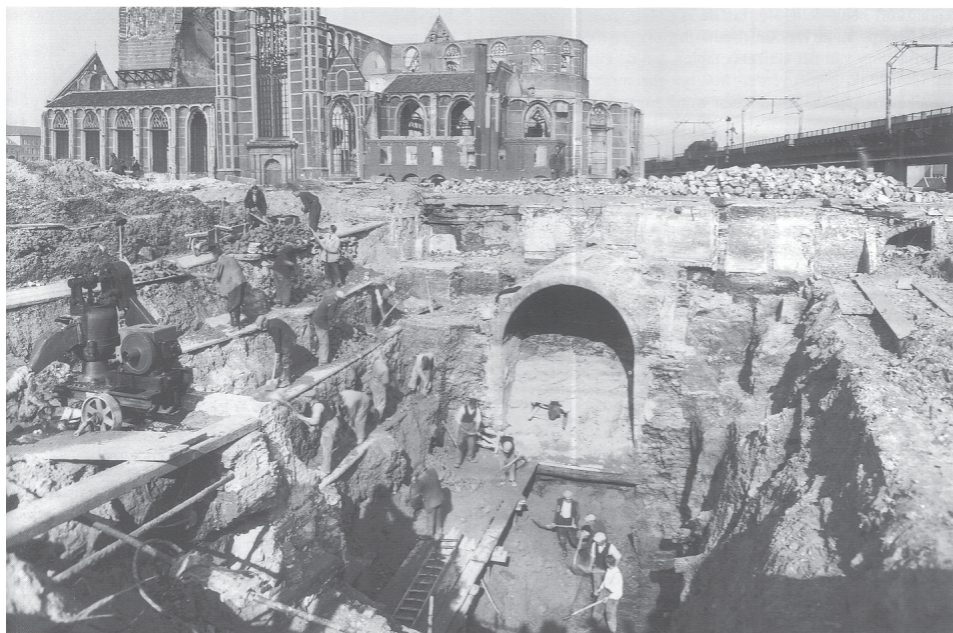
Het vrijleggen van de grote Keizerinnesluis in 1942/43 met op de achtergrond de door het bombardement beschadigde Laurenskerk (foto DIWERO 1942).
