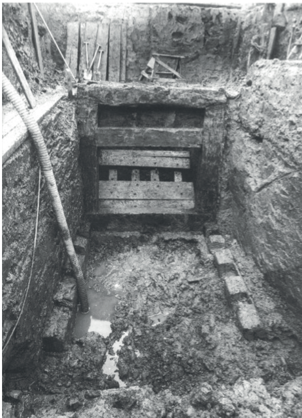
Sluis in de Nauwe Kerkstraat (foto DIWERO 1942). In 2024, bij de bouw van Rotta Nova, legden de Rotterdamse archeologen ook de toegang tot deze sluis bloot, evenals die bij de Zevenhuizersluis.
