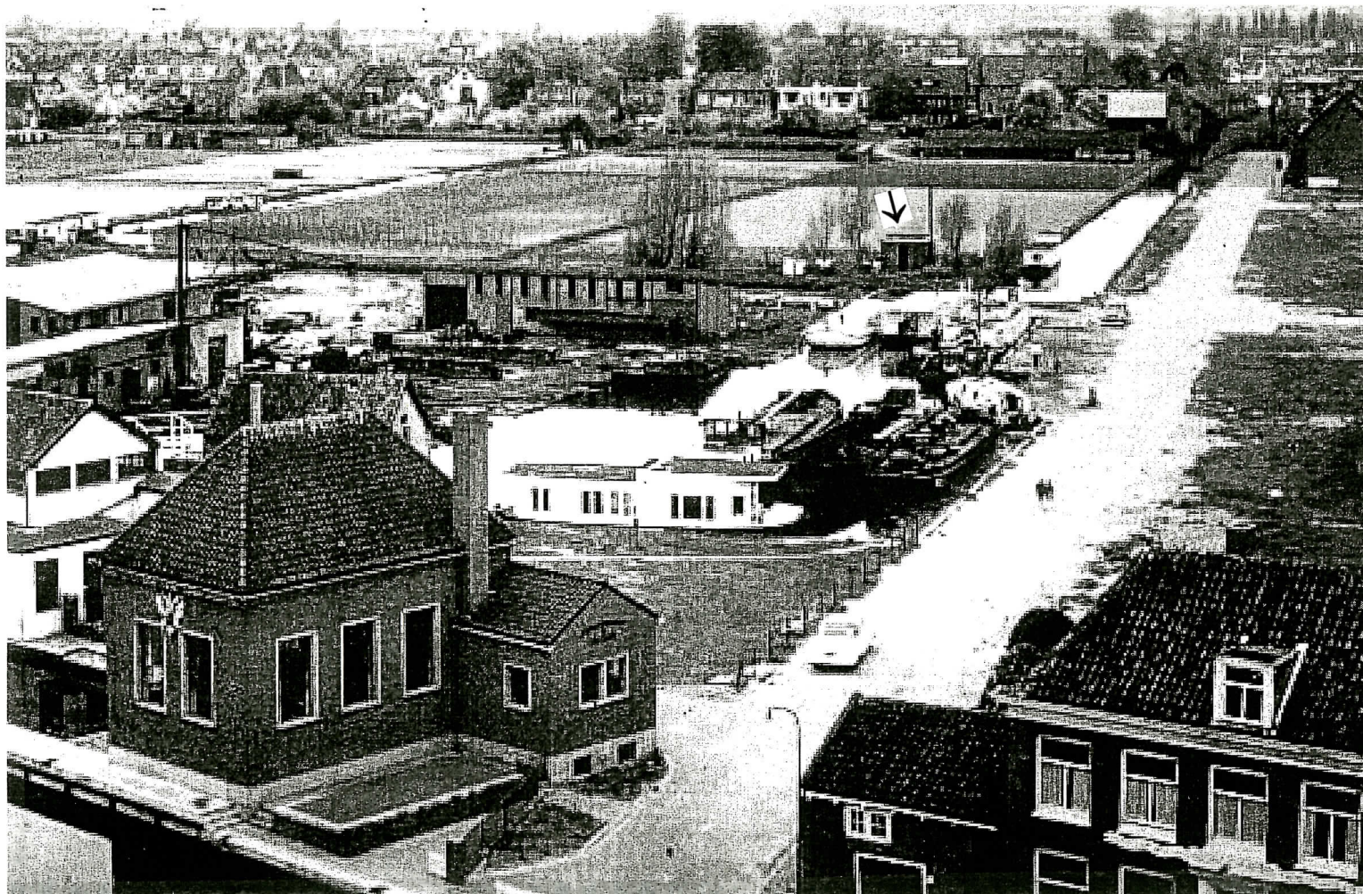
1.6.5. Delflands inlaatgemaal (boezemgemaal) mr. dr. Th.F.J.A. Dolk (ingebruikneming in 1953) aan de Leidsche Vliet en aan het snijpunt Sluiskant (Sluiskade) - Plaspoelkade, op het gedempte gedeelte van de Zandsloot (in 1952 omgelegd), en scheepswerfje van Van Ravesteyn, gezien vanaf de Hervormde dorpskerktoren in westelijke richting naar de Voorburgseweg. Locatie poldergemaaltje bij zwarte pijl, jr. 1957
