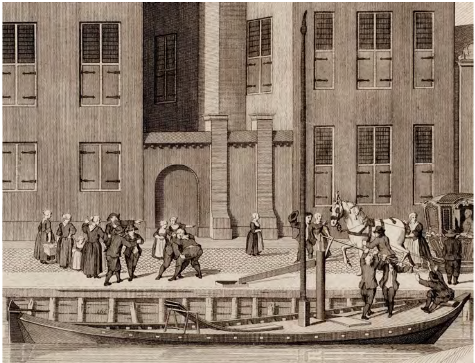
Afbeelding 3. Schuifwater wordt via een houten gootje, een luik in de straat en een (hier niet zichtbare) ondergrondse pijpleiding in een regenbak van het Aalmoezeniersweeshuis geleid. Jan Punt, Cornelis Pronk en Jacob de Wit, 1758 (detail) (Stadsarchief Amsterdam).
