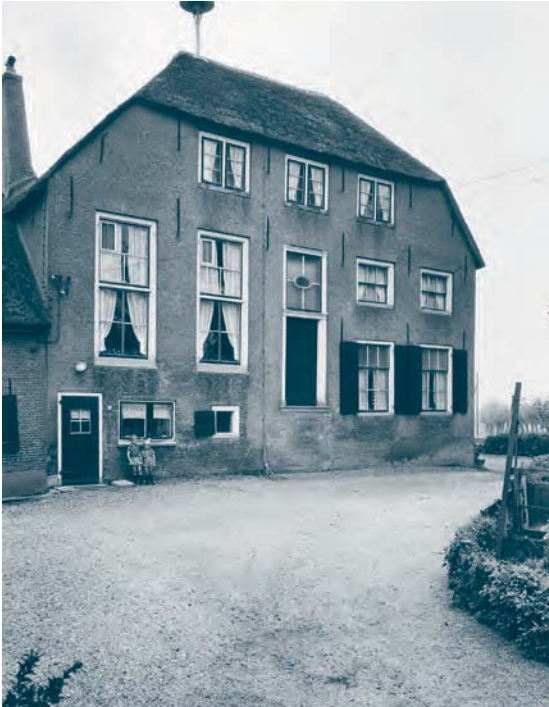
Afb. 7. Het Hooge Huys, Ottoland 30-32 in Ottoland: aan de hoge vensters, links in de gevel, is zichtbaar waar zich de waterkamer bevindt. In het midden van de gevel bevindt zich de vloeddeur. Fotoarchief Rijksdienst voor het Cultureel Erfgoed.
