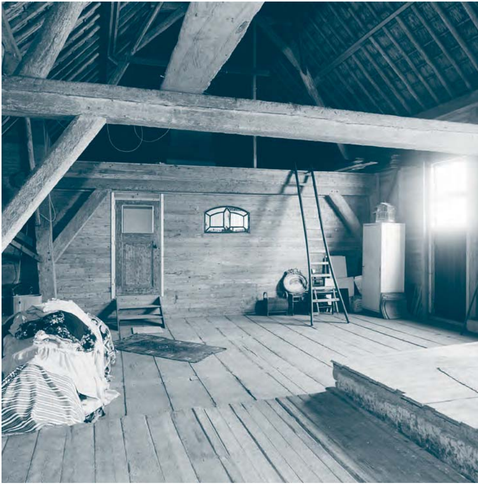
Afb. 6. Smalzijde 12, Nieuwland: op de zolder is een hoogteverschil waar te nemen, rechts op de foto, dat dienst deed als waterzolder. Dit gedeelte was verzaamd uitgevoerd om het gewicht van het vee te kunnen dragen. Fotoarchief Rijksdienst voor het Cultureel Erfgoed.
